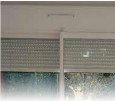
La grille d'entrée d'air intégrée à la fenêtre est **obligatoire** dans les pièces de vie (excepté les habitations équipées d'une VMC double flux).
