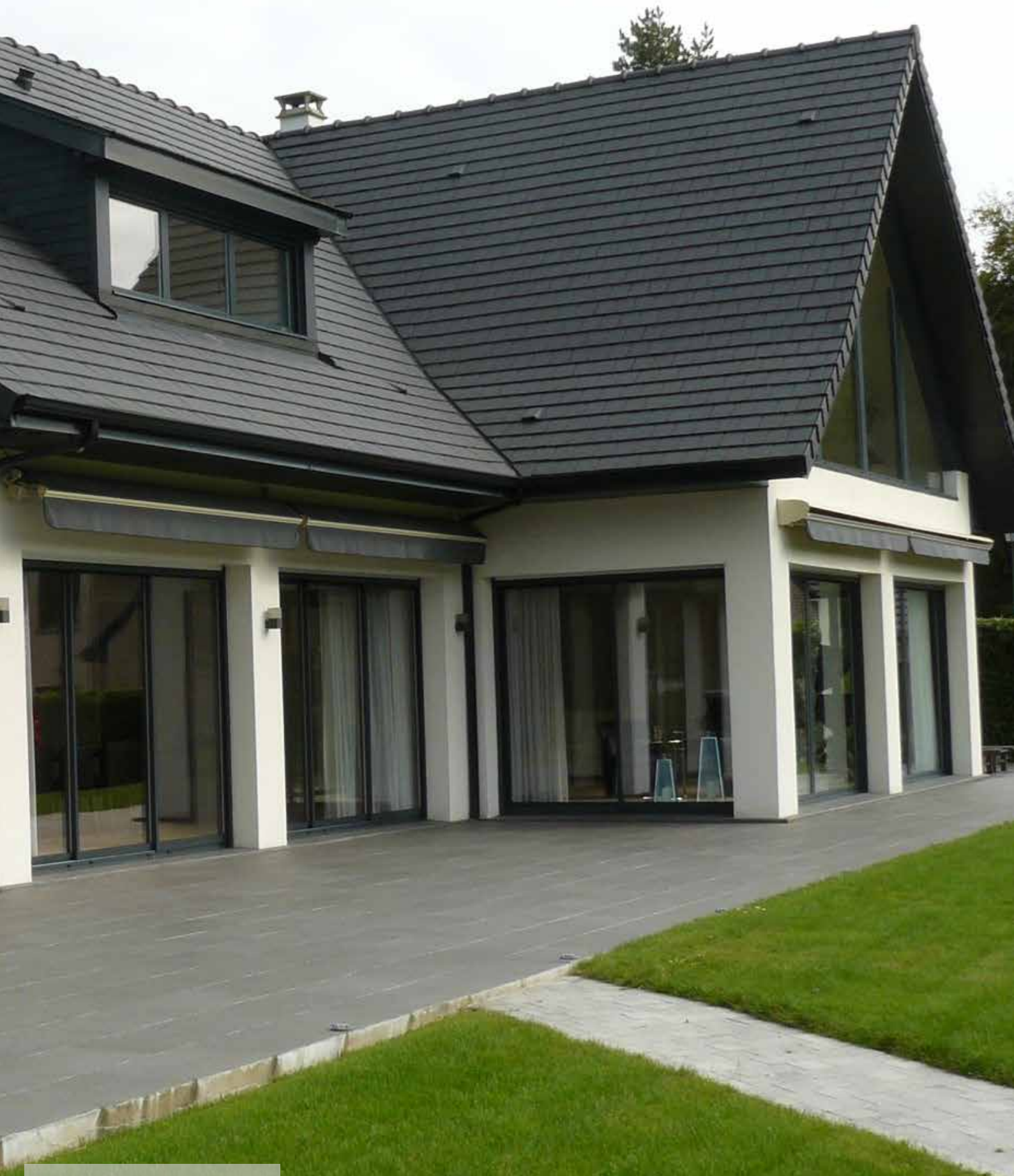
Chantier réalisé à Hardelot (62)
