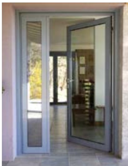
Porte totalement vitrée
