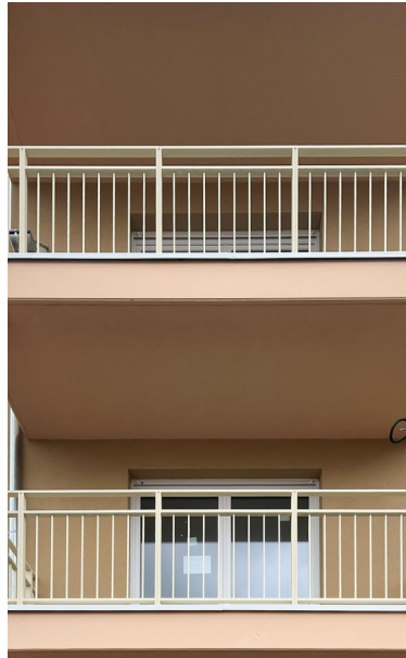
Barreaux sous main courante
